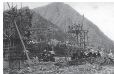
大糸線工事／昭和9年
