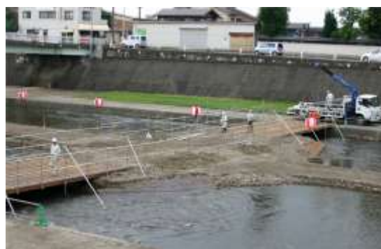
夏祭り会場設営～仮橋設置
